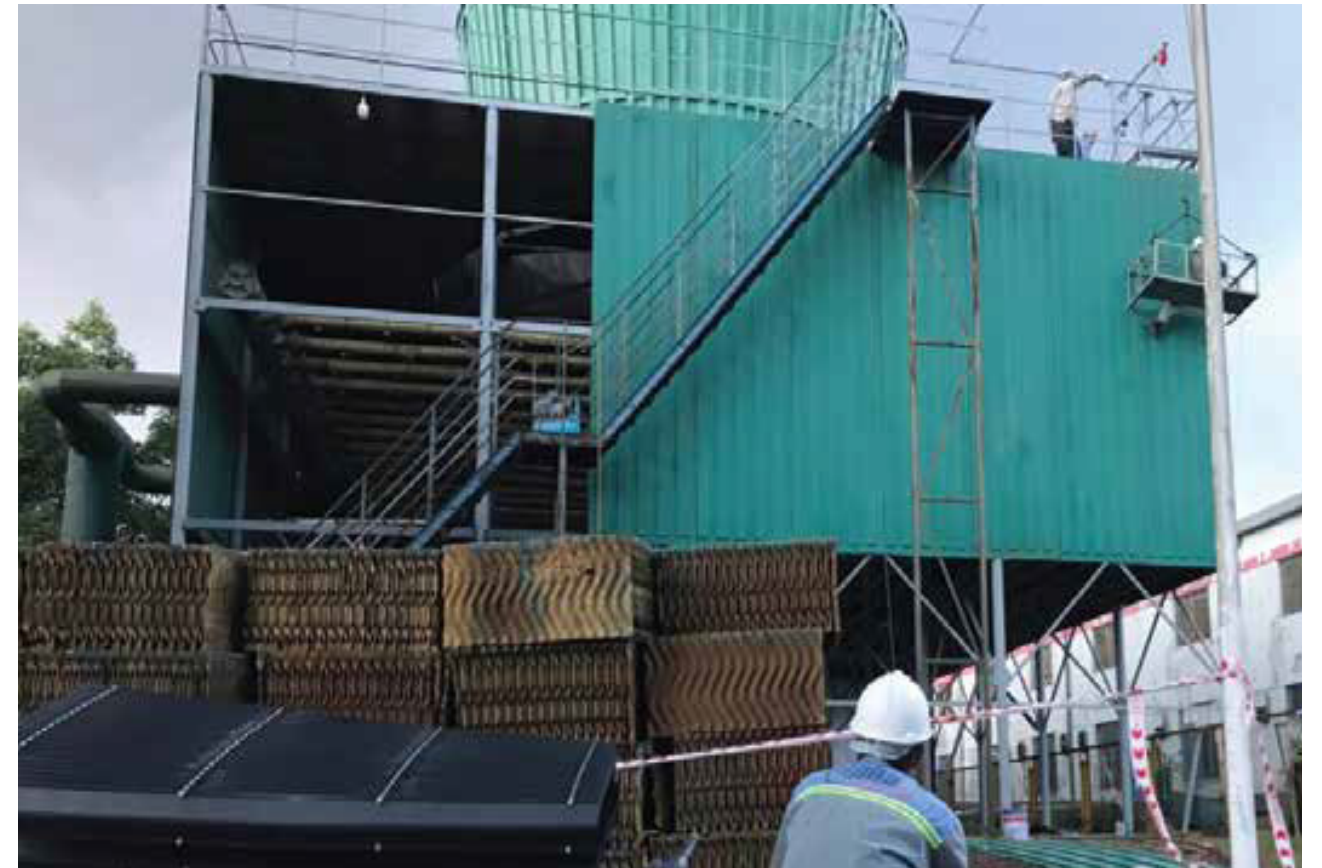
NHÀ MÁY NHÔM ĐAKNONG APF-1500RT
