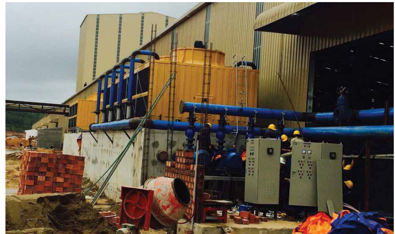
NHÀ MÁY TÔN HOA SEN PHÚ MỸ, BÀ RỊA VŨNG TÀU - APC-S-1500
