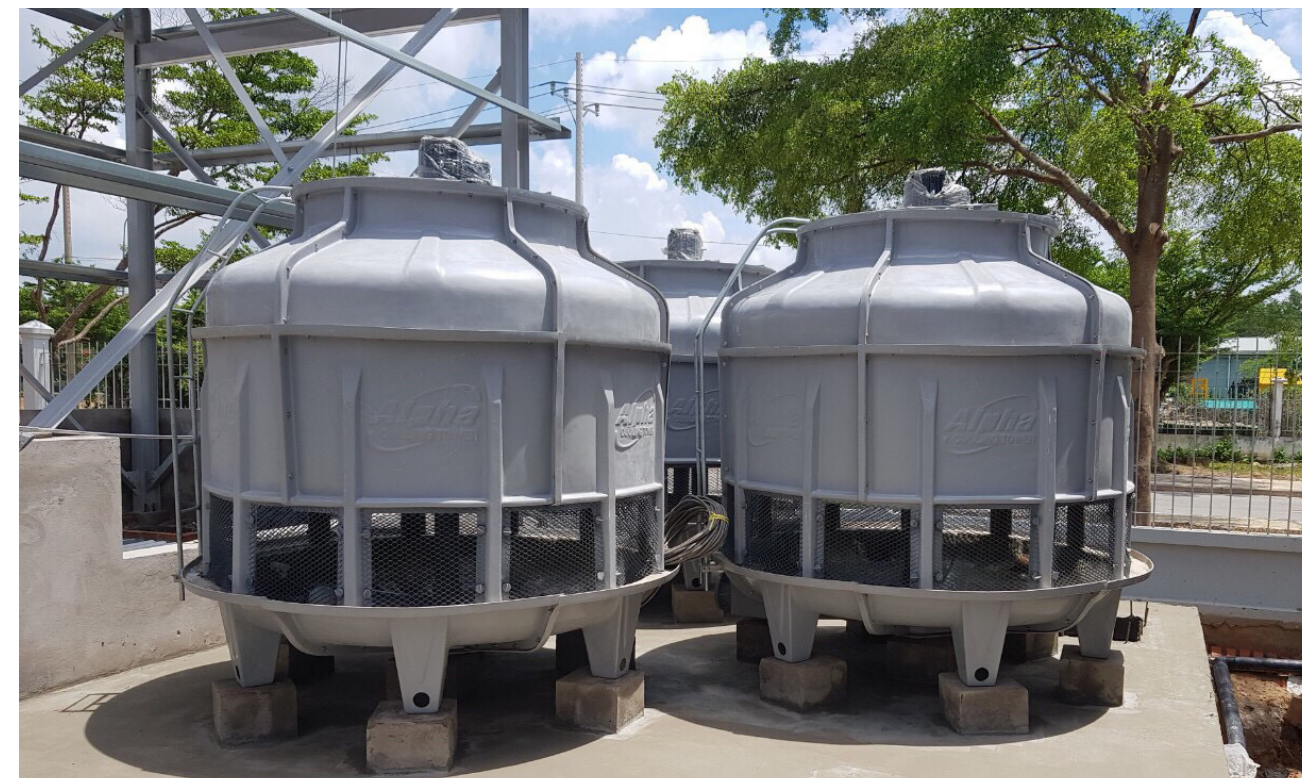
NHÀ MÁY AUSTDOOR NHƠN TRẠCH ĐỒNG NAI
